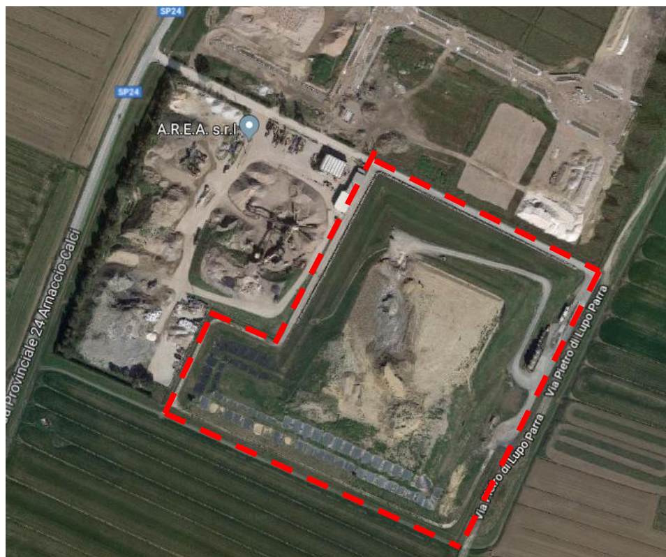
Figura 1 Area in cui sorge l'impianto
